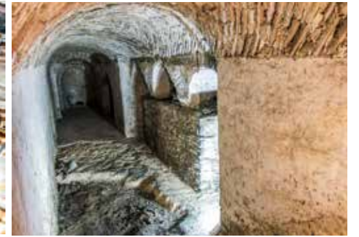
Şekil 14. Batı duvarından doğuya kuzey altyapısına bakış
