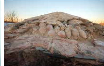
Resim 11-12. Duvarların restorasyon öncesi ve raspa sonrası görünümü
