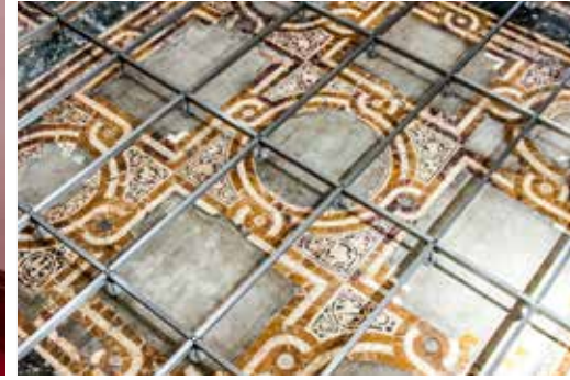
Şekil 13. Opus sectile döşeme üzerine yapılan paslanmaz çelik konstrüksiyon
