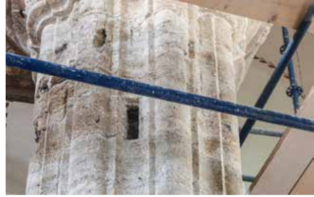
Şekil 8. Güney yapı kuzeybatı sütunu içinde tespit edilen granit sütunun yeri
