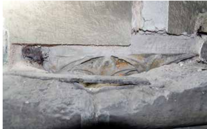
Şekil 7. Güney yapı güney sütunları üzerindeki 12.yy palmet yapraklı özgün mermer başlık detayı
