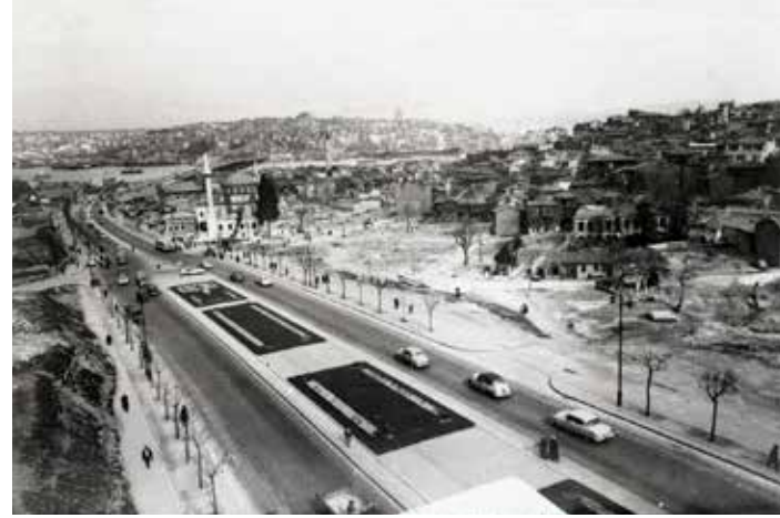
Çarşı'nın inşa edileceği bölge, “İstanbul Manifaturacılar Çarşısı Proje Müsabakası.” Arkitekt , sy. 291 (Şubat 1958) 87–92.
