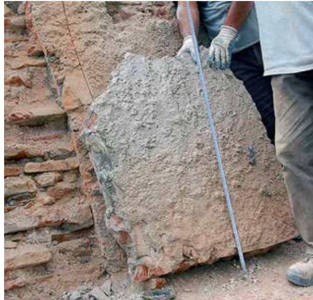
Şekil 2. Güney yapı kubbesi üzerindeki blok halinde kopan çimento harçlı dolgu
