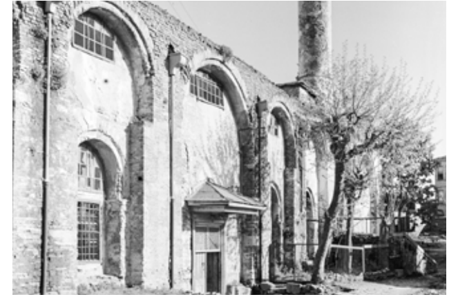
Şekil 6. Batı cephe, Artamonoff, 1938 (Dumbarton Oaks Arşivi)
