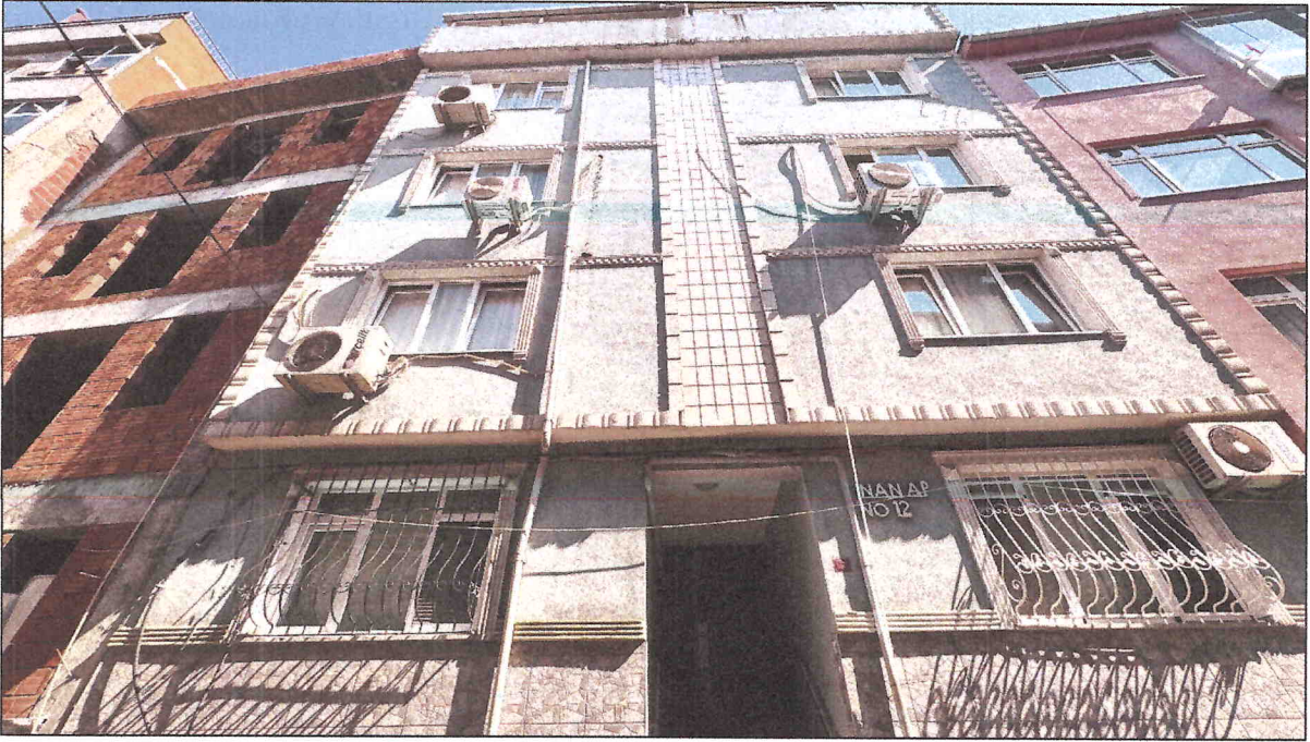
Şekil 6: Planlama Alanının Öksüzce Cami Sokağı Üzerinden Görünümü. 1
