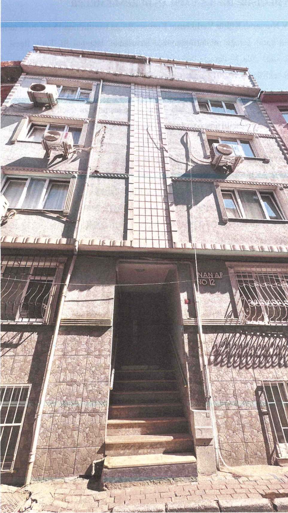
Şekil 7. Planlama Alanının Öksüzce Cami Sokağı Üzerinden Görünümü.2
