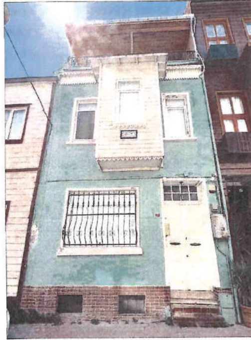
Şekil 7: Planlama Alanının Dönüş Sokak Üzerinden Görünümü
