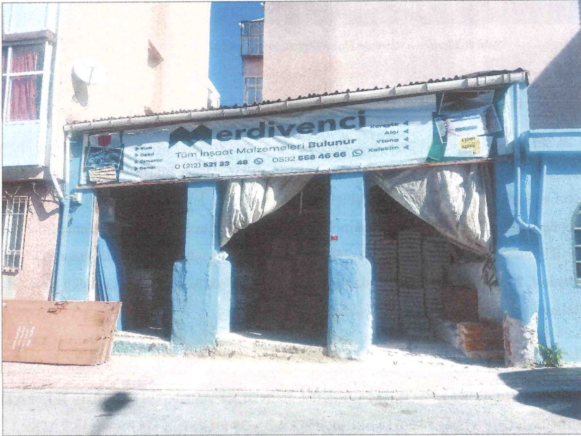
Şekil 7: Planlama Alanının Hasan Fehmipaşa Caddesi Üzerinden Görünümü.1
