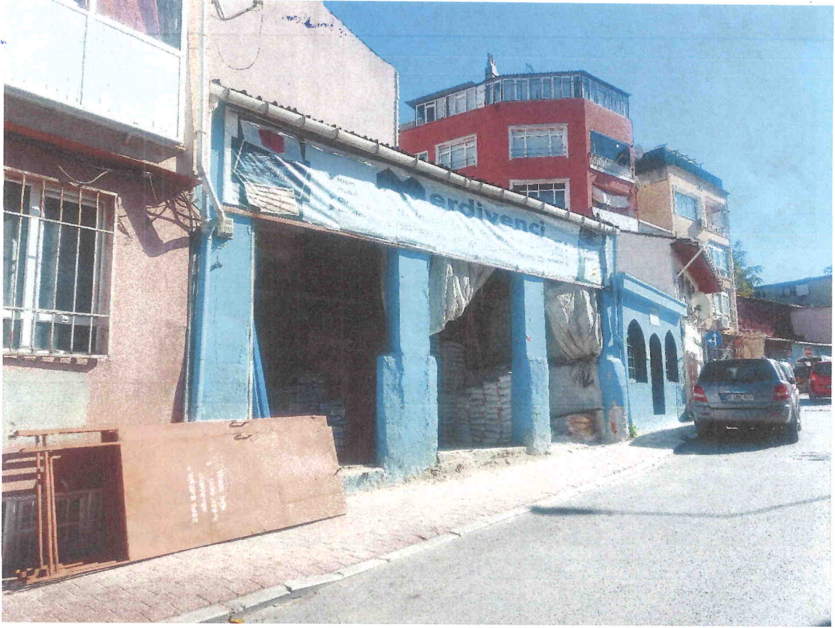
Şekil 8. Planlama Alanının Hasan Fehmipaşa Caddesi Üzerinden Görünümü.2
