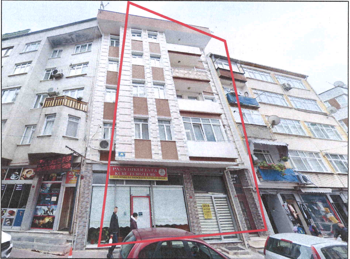
Şekil 7: Planlama Alanının Cambaziye Mektebi Sokak Üzerinden Görünümü
