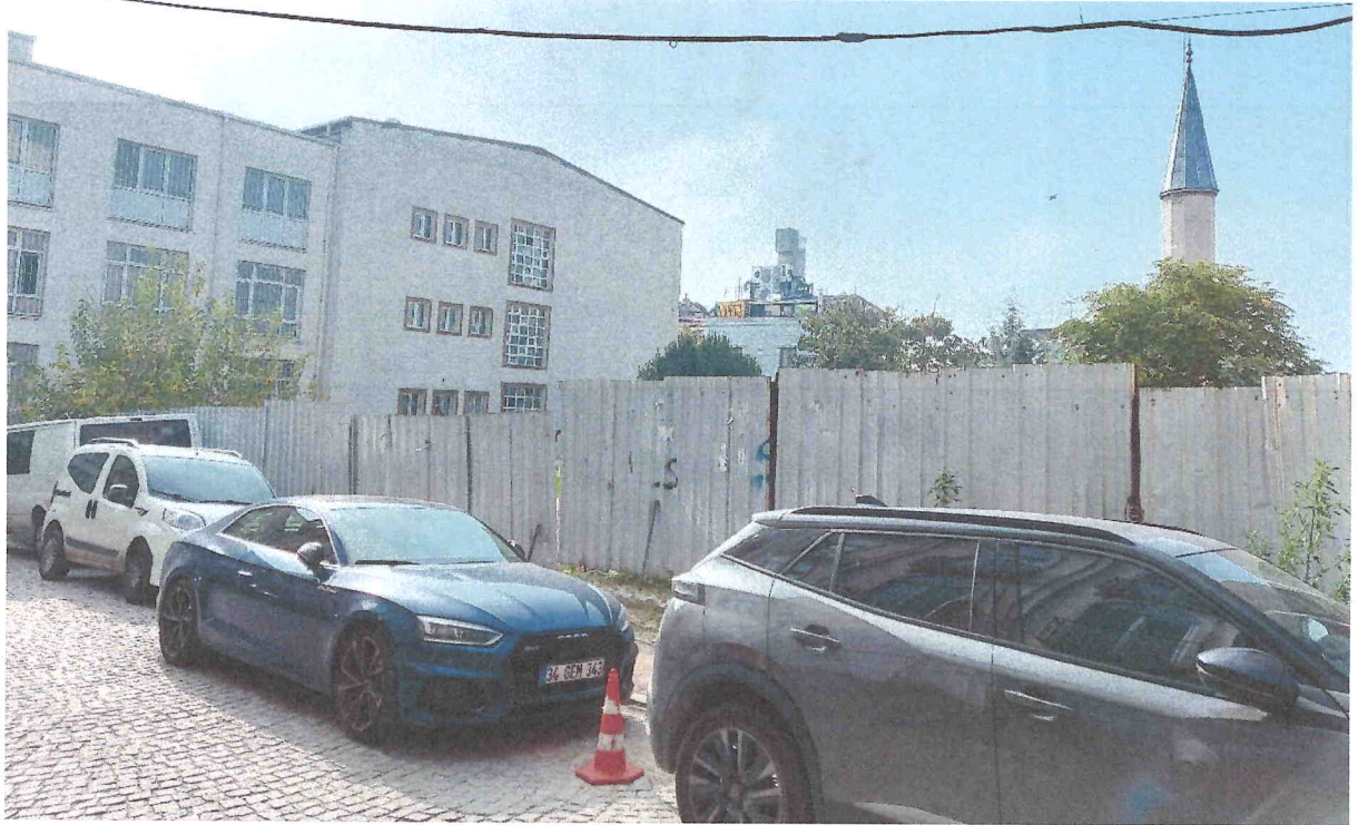
Şekil 9. Planlama Alanının Dizdariye Medresesi Sokağı Üzerinden Görünümü.2
